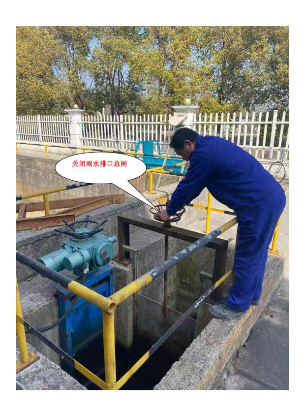
2.根据现场总指挥的指令,打开雨水收集池总闸,将受污雨水集中收集,开启水泵将收集的受污雨水送至污水处理站进行处理
